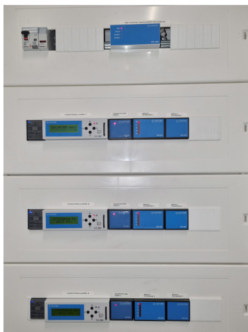
Quadro elettrico di regolazione
